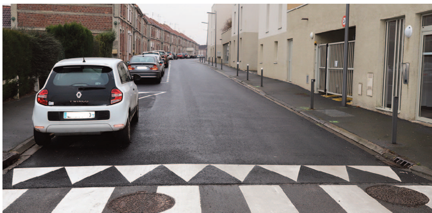
Rue de Savoie : après plusieurs semaines de travaux, l'entreprise Eurovia a finalisé la pose des enrobés et le marquage au sol pour circuler en toute sécurité.
