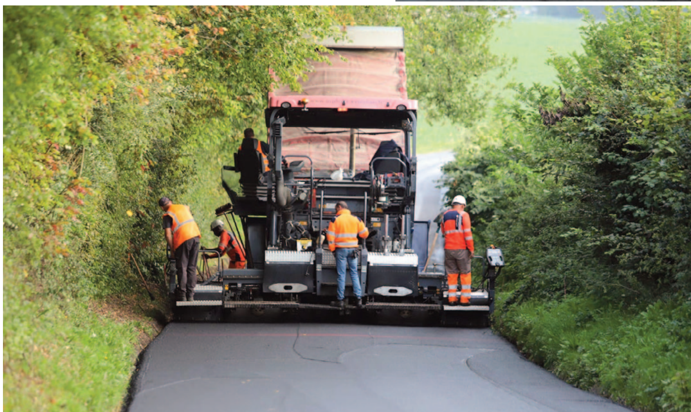
Rue du Corps du Bois (avant)
